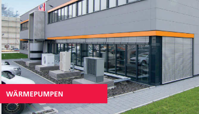
Installation von Luft/Wasser-Wärmepumpen vor dem TWK-Gebäude
