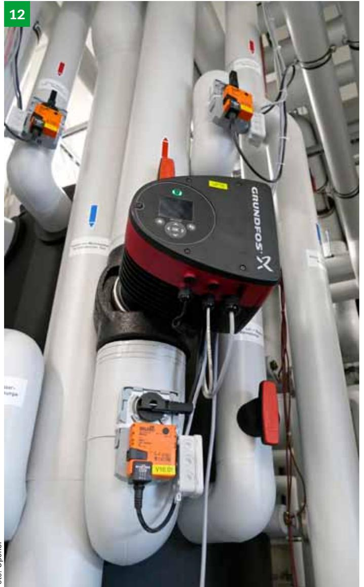
**Hocheffizienzpumpe mit Wärmemengenmesser und Motor-Kugelhahn mit Volumenstrom-Voreinstellung**
